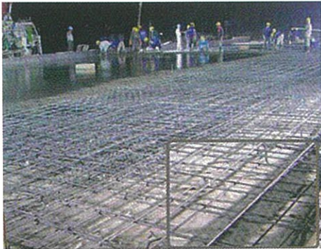
งานพื้นลานจอดรถ (Flat slab)
