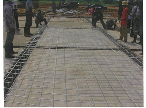
งานพื้นโรงงาน (Slab on beam)
